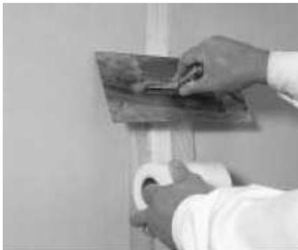
Applicazione **Adesivo per nastro di armatura HD** e copertura fissaggi:
